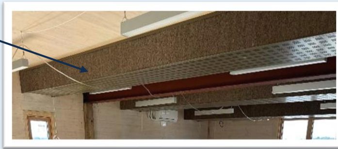
Tang fra Søuld for isolering
