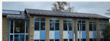
Skole bygning Himmelev
