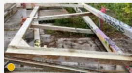
HAL 12 Stålstolper, firkantrør og I-profil
