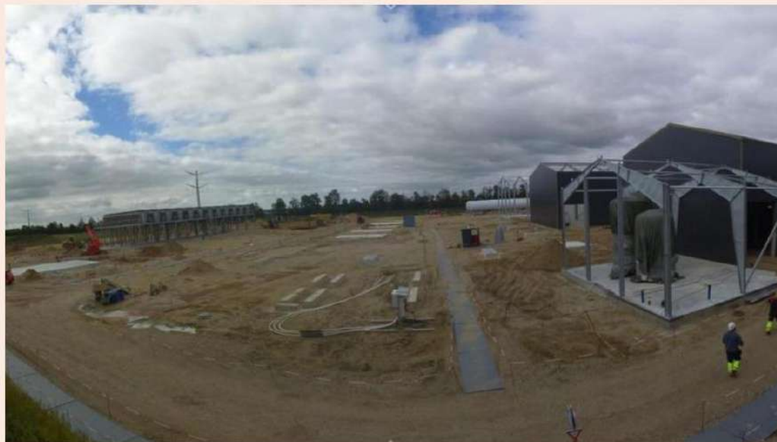
📍 Byggeriet af Kasso-anlægget, som det ser ud på European Energys live cam lige nu. Foto: European Energy
